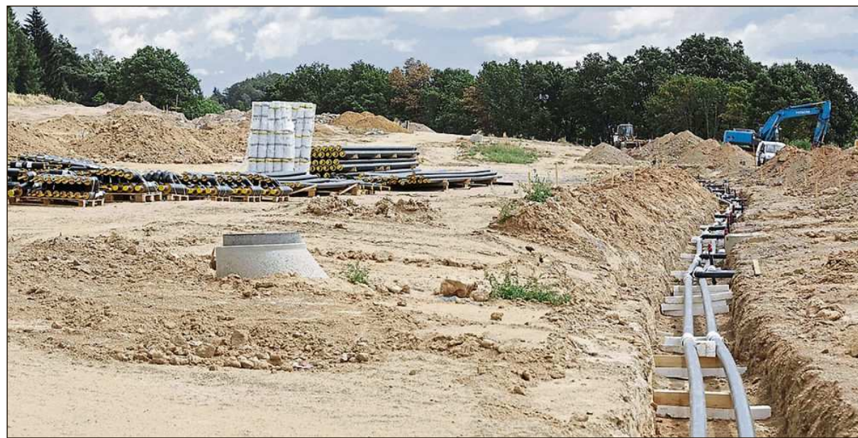
Die Wärmeleitungen am Baugebiet Roither Berg in Wenzelbach.
